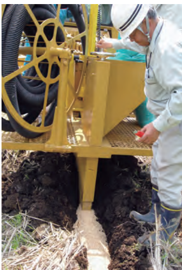
幹線パイプの埋設と同時に籾殻を施す
