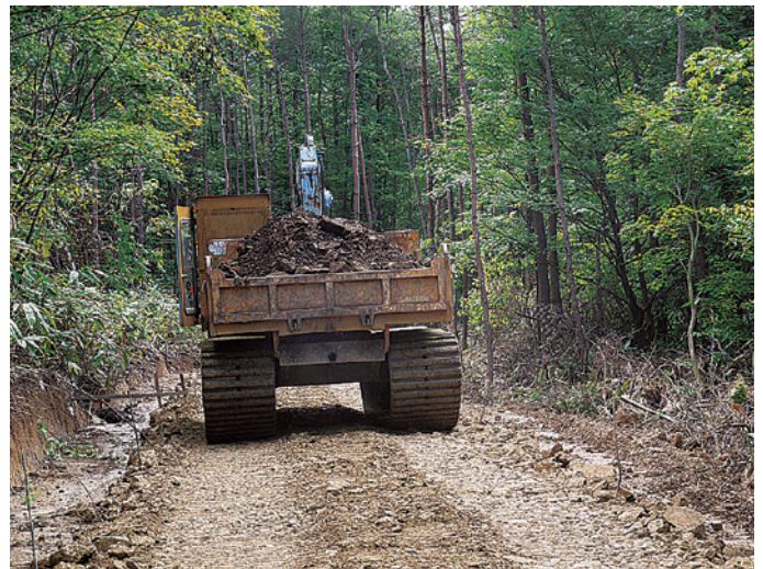
基幹作業道(路盤材運搬)
