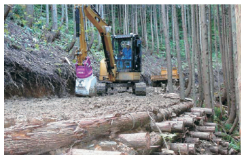
ザウルスによる作業路作設(7林班)
