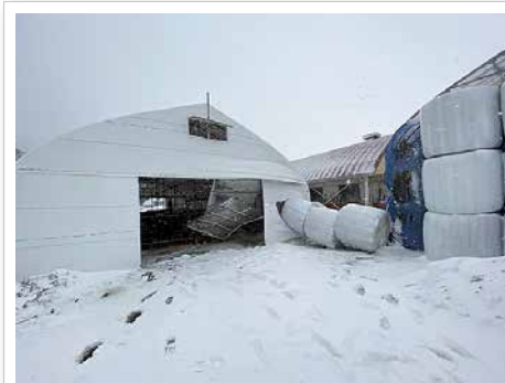
2月16日の大風で、御明神牧場オス子牛育成ハウスの扉が吹き飛び、ロールサイレージが崩れた状況
