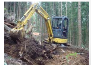
作業路の作設
