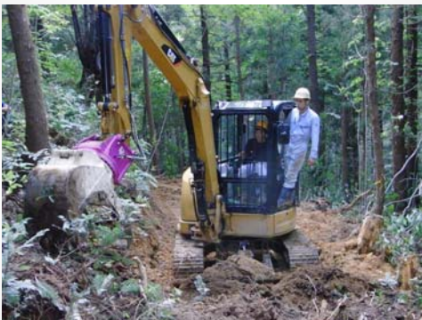
作業路の作設
